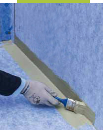
Applikation des Klebstoffs planeo SafeProtect WP Klebstoff im Wand-Boden-Bereich vor dem Aufbringen des Dichtbandes
