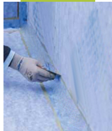
Applikation von einem Dichtband
