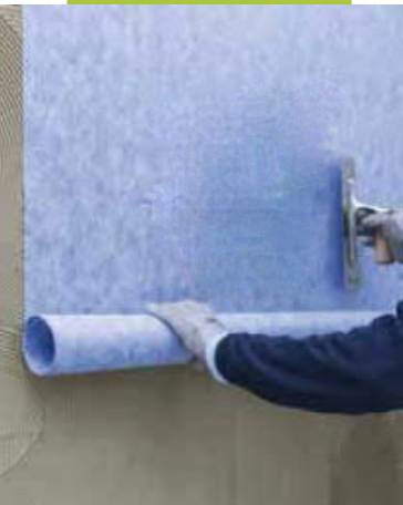
Verkleben von planeo SafeProtect Abdichtbahn
