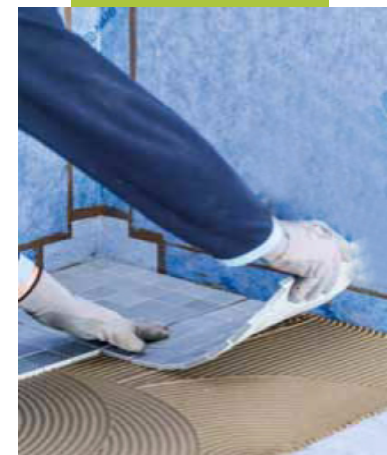
Verlegung von Fliesen
