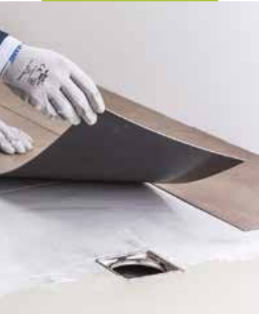
Verlegung von Designbelägen mit planeo Safebond Eco in Nassbereichen
